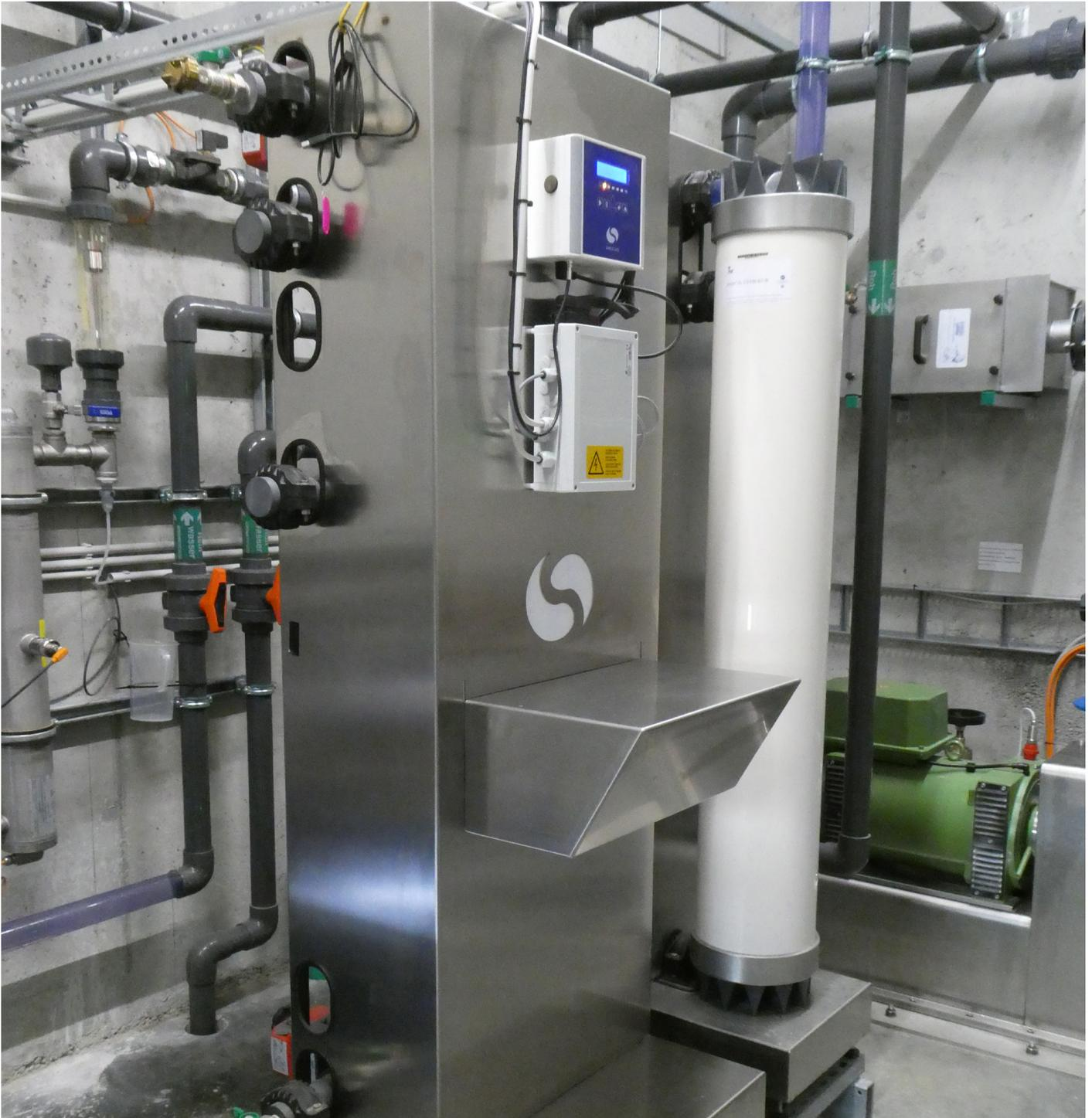
Die Seccua-Ultrafiltrationsanlage benötigt wenig Aufstellfläche. Der modulare Aufbau erleichtert das Einbringen in das Technikhaus und die Installation.
