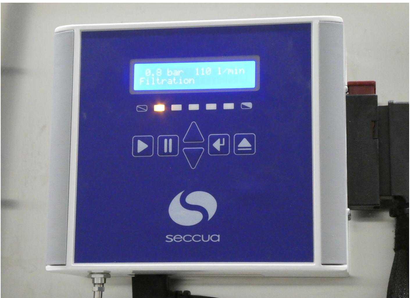
Die Steuerung der Phoenix-Ultrafiltrationsanlage passt die Spülzyklen der Wasserqualität an.
